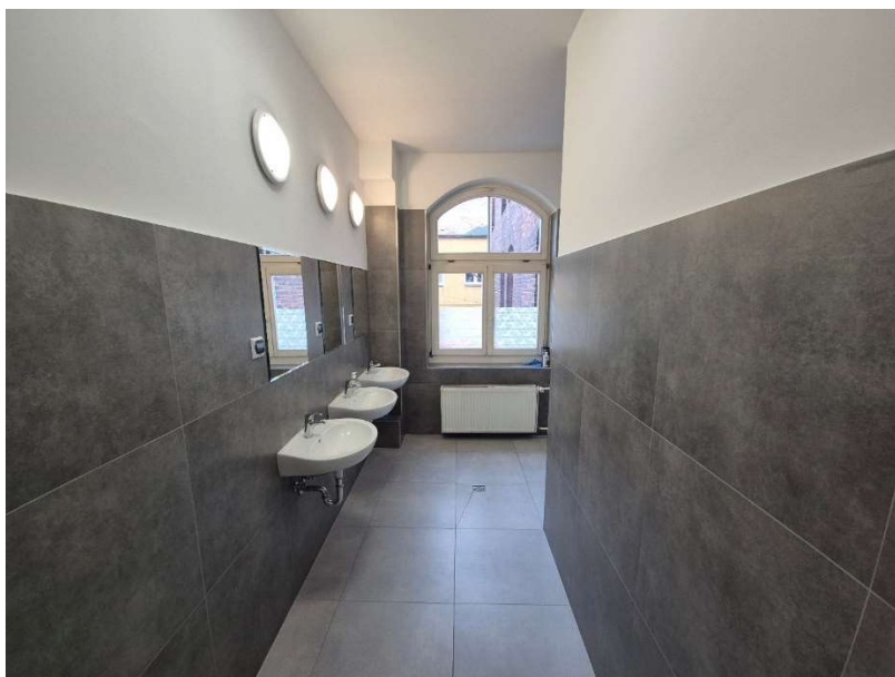
Zdjęcia nr 8. JRG-8 łazienka podziału bojowego po remoncie.
